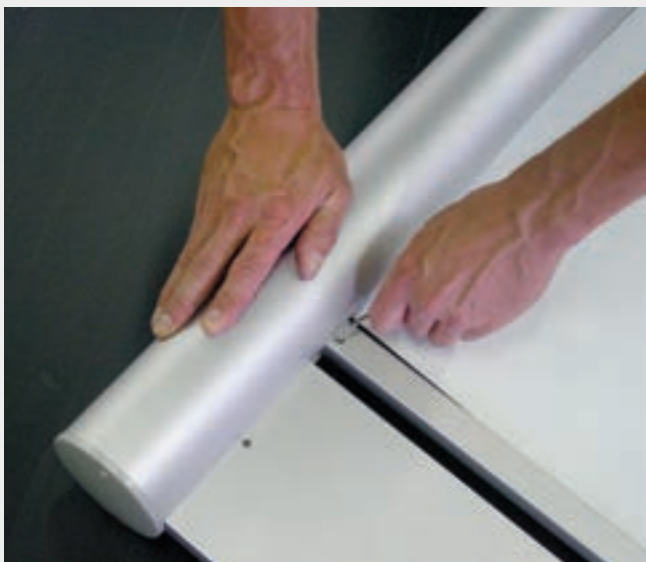
Festschrauben eines H-Profiles an der Säule mittels Inbusschlüssel
